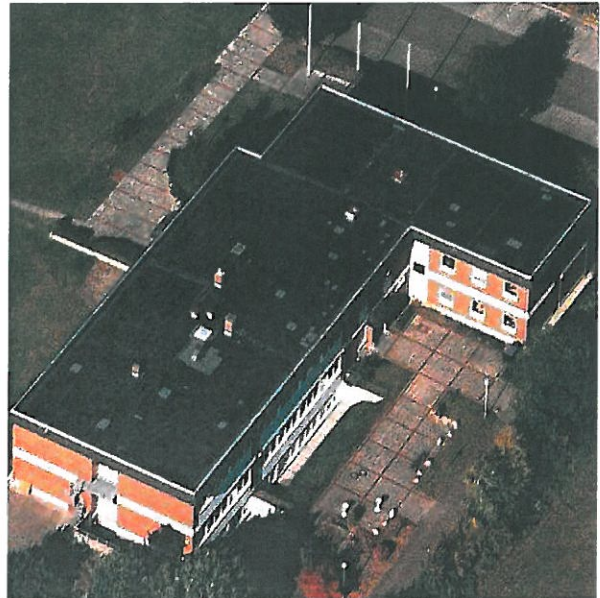
Luftaufnahme: Auf dem Dach des Schulgebäudes der Landwirtschaftskammer in Osterrönfeld könnte eine Fotovoltaik-Anlage installiert werden. RAABE
